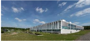
07_Die WITTENSTEIN Innovationsfabrik, Außenansicht, in Igersheim-Harthausen
