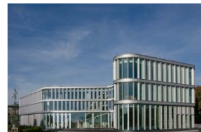
Das Gebäude der NanoFactory in Haar – Nanotechnologieschmiede im Osten Münchens.
