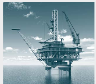
Öl- und Gasexploration
